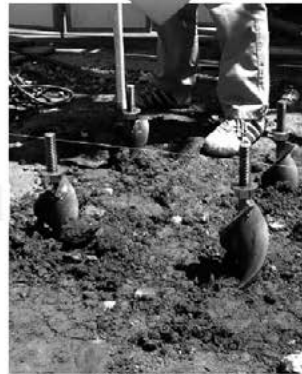
スパイク打ち込み完了
