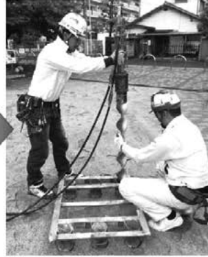
専用ガイドに沿ってスパイクを打ち込み
