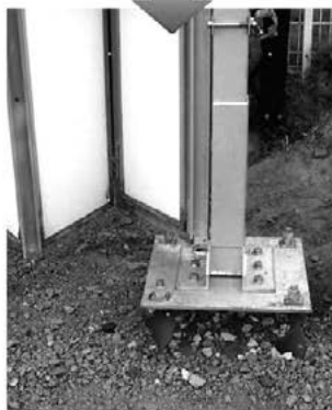
各部材取り付け
